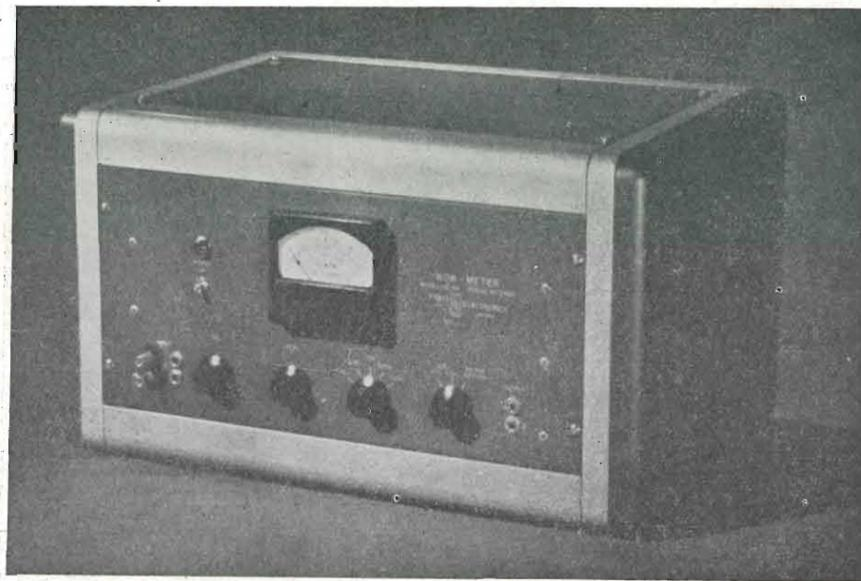
Lo strumento illustrato qui sopra è destinato alla misura diretta delle variazioni (*wow*) di velocità di: a) giradischi a nastro, b) registratori a filo magnetico, d) equipaggi per cinematografia. E' il modello 115-RA costruito dalla Furst Electronics, Inc. La lettura è eseguita su tre scale commutabili, (0,2%, 0,5%, 2% di variazione di velocità) mediante apposito comando manuale.
