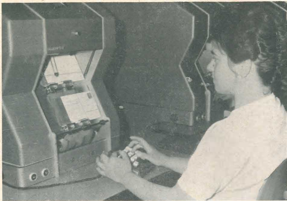
Fig. 3 - Un posto di codificazione. L'iscrizione del numero caratteristico di quattro cifre avviene in ciascun posto codificatore corrispondente agli indirizzi. La marcatura appena visibile per l'occhio umano, viene rilevata elettronicamente dalla macchina smistatrice. A questo modo è possibile smistare 20.000 lettere all'ora in 100 direzioni.
