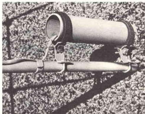
I rumori che vengono trasmessi da un'antenna TV che vibra possono essere eliminati avvolgendo strisce di feltro intorno al tubo di supporto. Sulle strisce di feltro si piazzano poi le strisce metalliche e si stringono come, per esempio, si stringono i tubi che arrivano a un radiatore d'auto.
