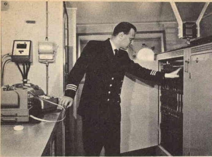
Questo sistema, uno dei primi installati in una nave cisterna, controlla e registra il funzionamento dei motori principali e dei servizi elettrici, la velocità della nave e le condizioni atmosferiche. I dati completi sono trasmessi giornalmente al centro Shell di Londra, dove vengono immessi in un calcolatore che fa parte di un programma di ricerche progredito.
