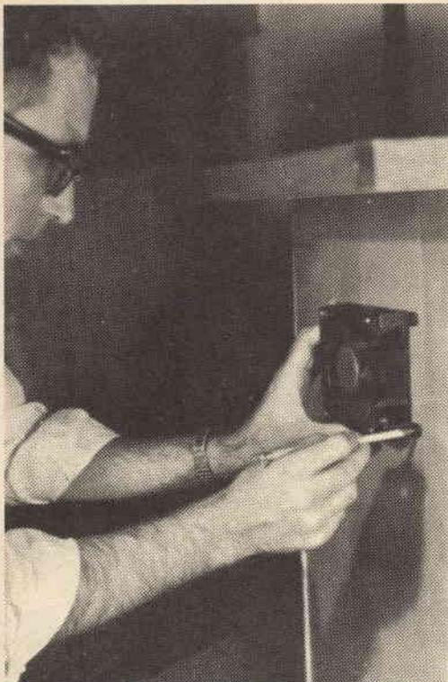
Il punto migliore per il montaggio del ventilatore è quello che permette una libera circolazione dell'aria. Marcate i fori di montaggio e tagliate l'apertura del ventilatore.
