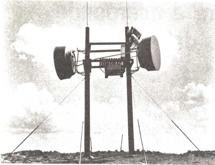
*Installazione commerciale del ripetitore a microonde fortemente semplificato della GTE Lenkurt, azionato dall'energia solare, sul monte Hunts Mesa in Arizona.*
