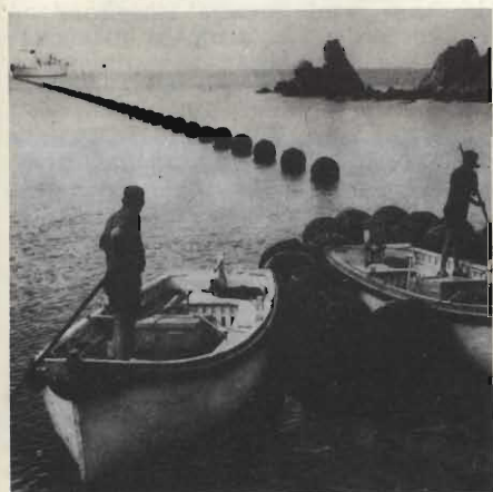
Fig. 8 - Malgrado la televisione, le comunicazioni via satellite, i collegamenti via cavo sono in netto aumento. La figura illustra l'ancoraggio ai un cavo sottomarino.
