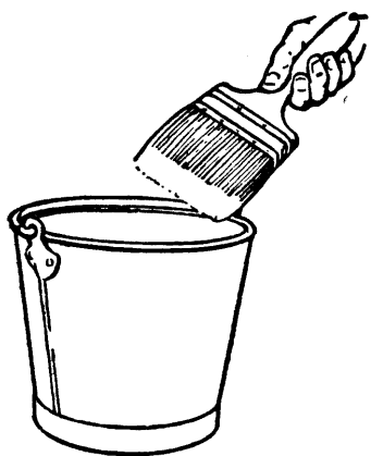
Fig. 29 - Per l'imbiancatura il pennello non deve né essere immerso completamente né essere troppo carico. Per questo battere due o tre volte le setole contro la parete del recipiente dopo averlo tuffato nel bianco per cinque cm. al massimo.
