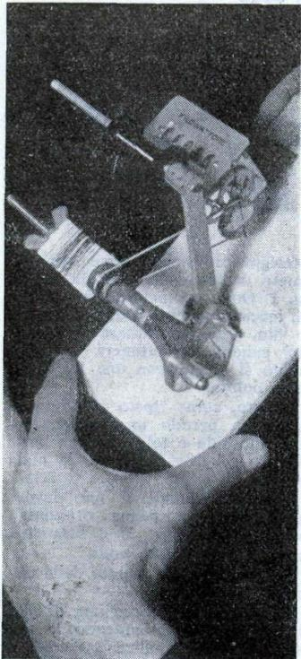
Come tutti coloro che si divertono a darsi da fare con la costruzione di piccoli apparecchi radio, sentivo da tempo vivo il desiderio di una bobinatrice fornita di contagiri, che mi permettesse di preparare le mie bobine con la certezza di non sbagliare nel numero delle spire occorrenti e mi evitasse il fastidio di stare a contarle una per una durante l'avvolgimento.
