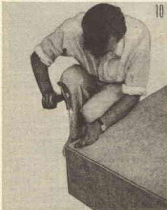
Gli ultimi chiodini vengono piantati nel pannello posteriore. In seguito non rimarrà che da lisciare tutte le superfici con cartavetro e stuccarle ove sia necessario, indi applicare su di esse un poco di mordente ed infine uno strato, a spruzzo, di smalto trasparente, alla nitro o sintetico. I ripiani vengono rifiniti separatamente e quindi sistemati al loro posto.
