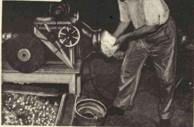
Caricamento della betoniera: per avere la certezza di rispettare le proporzioni tra i vari ingredienti, si preferisca misurare questi, invece che giudicarne la quantità ad occhio. — (In alto): Sistemazione all'interno del bidone, delle tre lame dell'agitatore.
