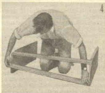
Quando si tratta di inchiodare l'elemento posteriore di base, si ponga il complesso sinora montato, contro muro e mantenendo verticale la parete laterale del mobile, si provvede a piantare ed a sprofondare i chiodi: questo è uno dei migliori sistemi per eseguire questa fase della lavorazione.
