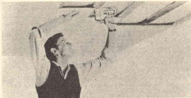
**FIG. 13** - i soffitti anti-fonici sono efficaci per assorbire i rumori che si producono nel locale, ma non quelli prodotti nei locali vicini. Per migliorare l'isolamento bisogna lasciare una camera d'aria di almeno 3 centimetri tra il soffitto e i pannelli isolanti.
